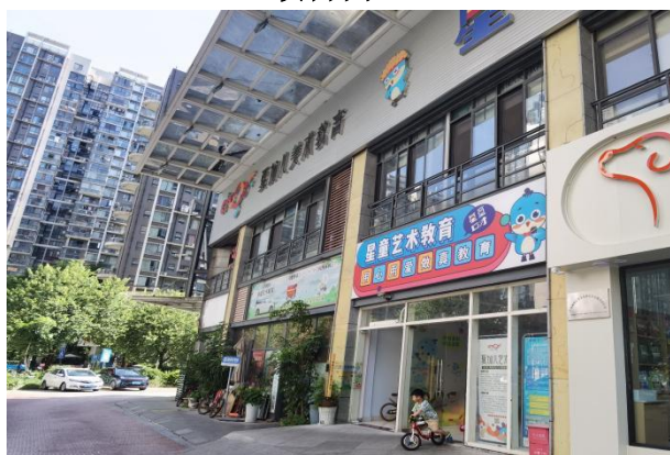
项目南侧商铺
